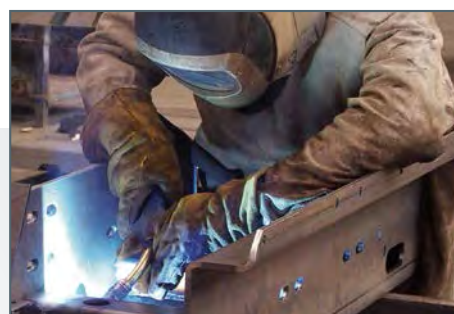
Saldatura di un gruppo saldato al telaio.
